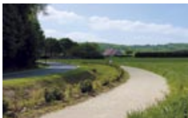
Un nouveau chemin agricole à Marcoussis, bordé d'un fossé de drainage
